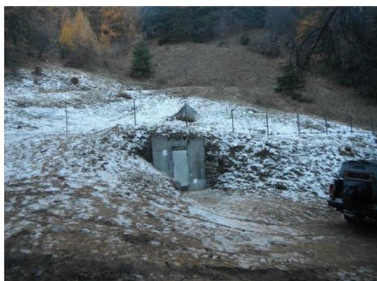
**Captage du Sapet.** Il se situe en rive droite du torrent du Gros Riou à une altitude de 1 568 m. Cette station permet de déterminer la qualité naturelle des eaux de la source.
