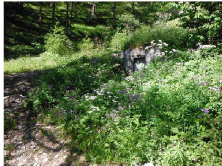
Vue du captage en été
